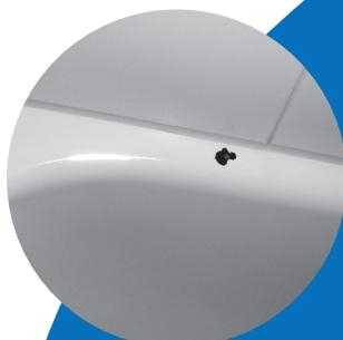
1. Bei der Beschädigten Stelle werden Verschmutzungen und lose Splitter entfernt und der Untergrund gereinigt.
