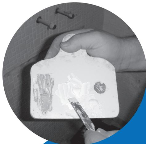
2. Mit einer 2-K Deckfarbe wird die Reparaturstelle abgedeckt.
